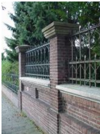
Bakstenen erf afscheiding.
